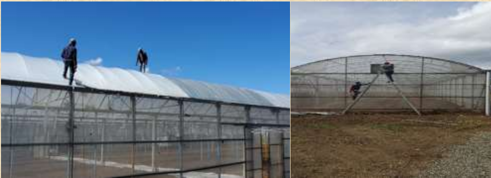
Reparación y acondicionamiento del invernadero de 4,800 m 2
