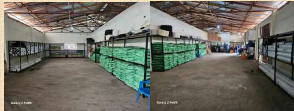
Reacondicionamiento y construcción de tramos del almacén
