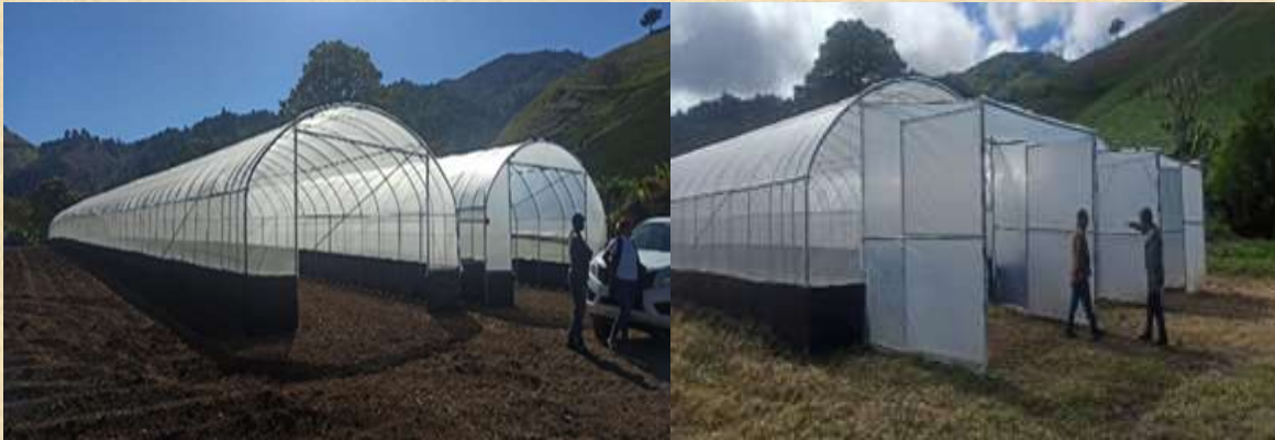
Instalación de invernaderos en fincas de productores de papa de Constanza
