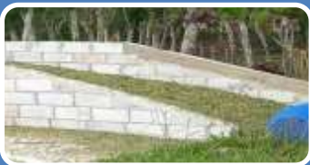
SILOS DE CAJÓN
